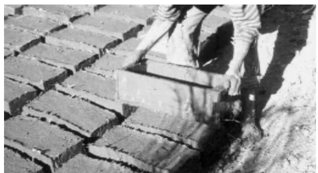
7-2 Proceso de elaboración de adobes en Ecuador
